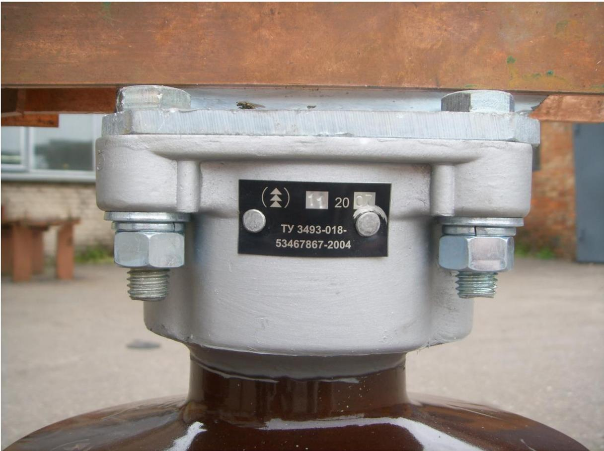
**Приложение 11** Вид на изолятор с табличкой электротехнического изделия (качающийся / поворотный изолятор).
